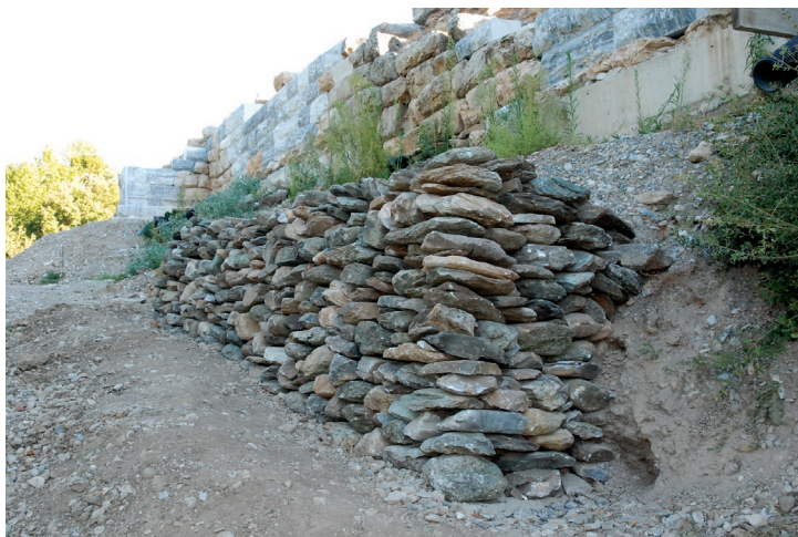
Ξερολιθιά ως υπόβαση του χωμάτινου πρανούς εξωτερικά του τείχους
