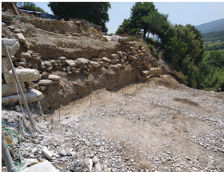
Ολοκλήρωση προσωρινής αφαίρεσης δομικού υλικού του νότιου μεταπυργίου για την κατασκευή της υποθεμελίωσης
