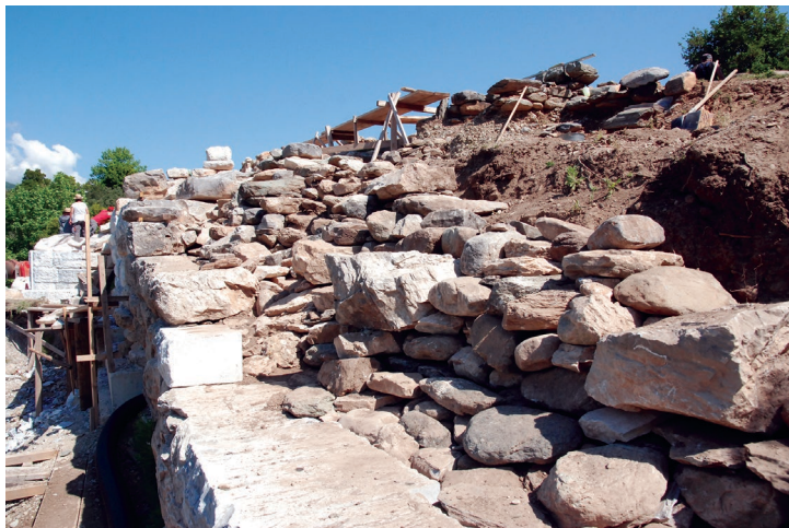
Σταδιακή αποκατάσταση της εξωτερικής παρειάς και του εσωτερικού γεμίσματος του νότιου μεταπυργίου
