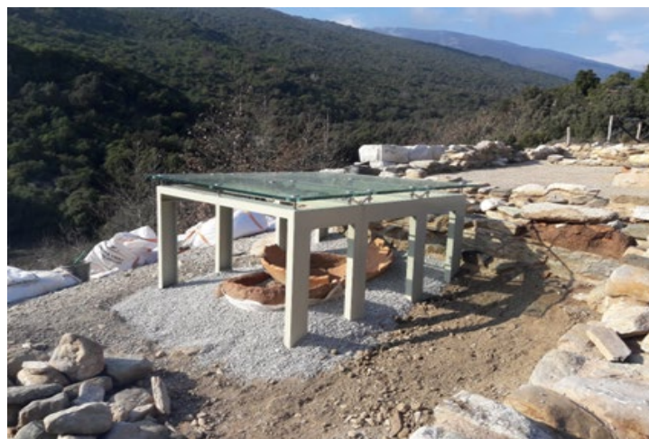
Άποψη των πίθων μετά τη διαμόρφωση υποστηρικτικών τοιχείων και αποστραγγιστικού υλικού (επάνω) και την τοποθέτηση του προστατευτικού στεγάστρου (κάτω)
