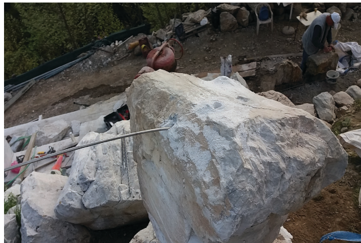
Διάτρηση λιθοπλίνθου για την τοποθέτηση μεταλλικού συνδέσμου ανοξείδωτου χάλυβα
