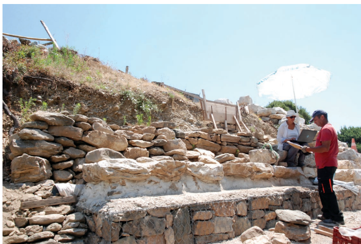
Βόρειο μεταπύργιο. Επανατοποθέτηση της ευθυντηρίας επί λιθοδέματος και λιθοπληρωμένων συρματοκιβωτίων
