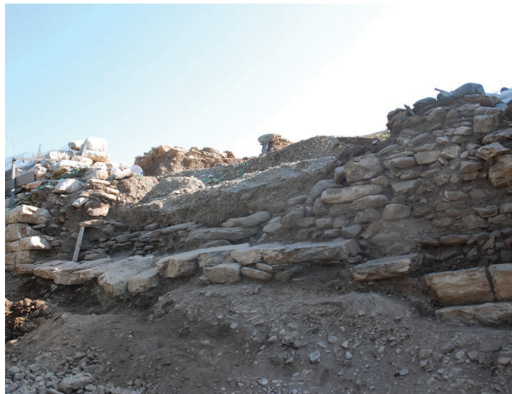
Εξέλιξη των εργασιών προσωρινής αφαίρεσης της εξωτερικής παρειάς του νότιου μεταπυργίου
