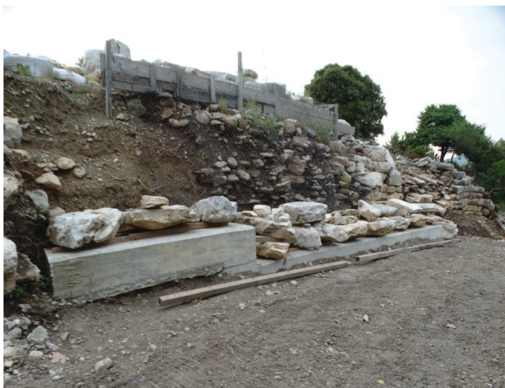
Σταδιακή επανατοποθέτηση των αρχαίων λιθοπλίνθων του πύργου επί θεμελίου
