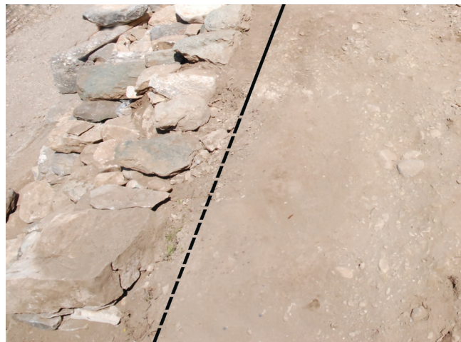
Η κοίτη θεμελίωσης κατά μήκος της εσωτερικής παρειάς του νότιου μεταπυργίου
