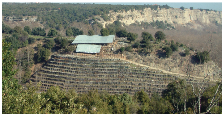
Αντιστήριξη του ΝΔ πρανούς του λόφου της ακρόπολης στο πλαίσιο του ΠΕΠ Κεντρικής Μακεδονίας (2003-2004)
