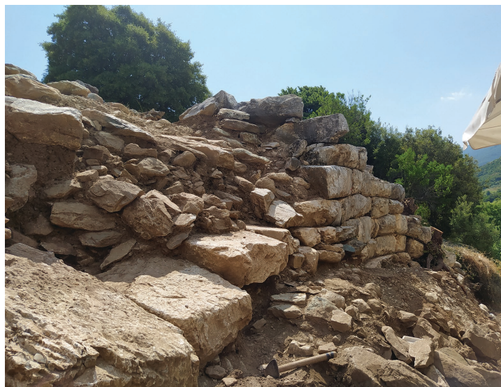
Άποψη του νότιου μεταπυργίου μετά την αποκάλυψη του θεμελίου
