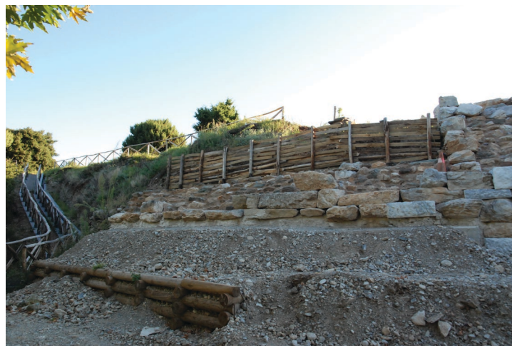
Αποκατάσταση πρανούς επί ξύλινου κρασπεδότοιχου
