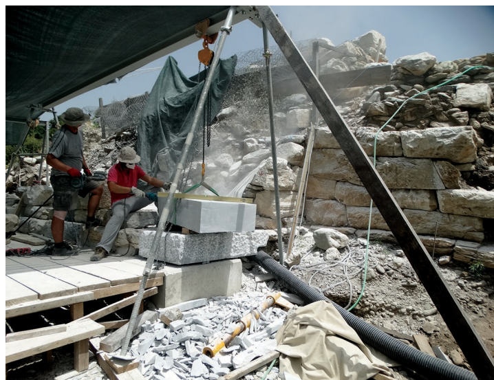
Επανατοποθέτηση αρχαίων λιθοπλίνθων και λάξευση νέων λιθοπλίνθων συμπλήρωσης της εξωτερικής παρειάς του πύργου
