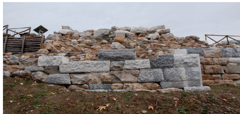
Άποψη της εξωτερικής (δυτικής) παρειάς του πύργου πριν (αριστερά) και μετά (επάνω) τις εργασίες συντήρησης και αποκατάστασης
