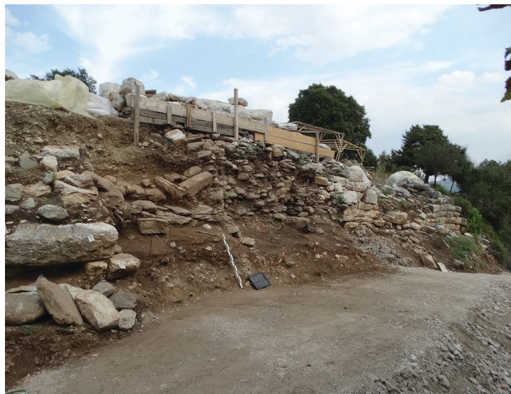
Ο πύργος μετά την προσωρινή αφαίρεση των λιθοπλίνθων της εξωτερικής παρειάς. Διακρίνεται το εσωτερικό γέμισμα από αργούς λίθους και χώμα
