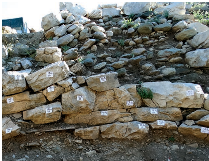
Αρίθμηση των λιθοπλίνθων εξωτερικής παρειάς του πύργου πριν την απόσπασή τους
