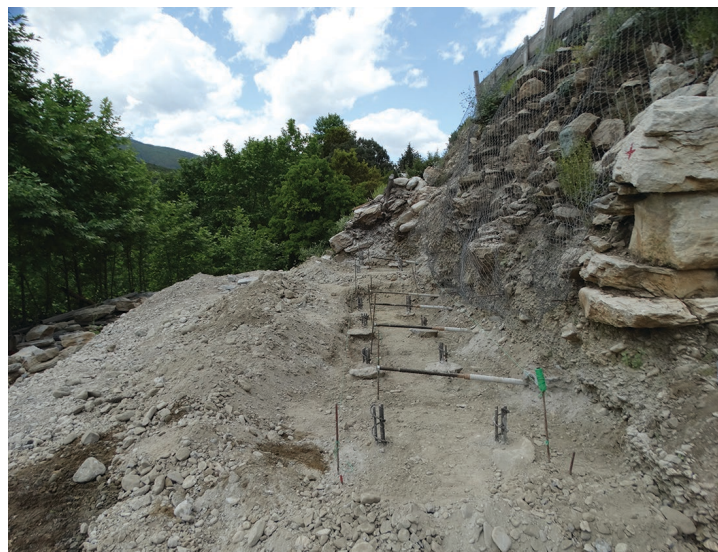
Τοποθέτηση εδαφοηλώσεων και μικροπασσάλων στην υποθεμελίωση του πύργου
