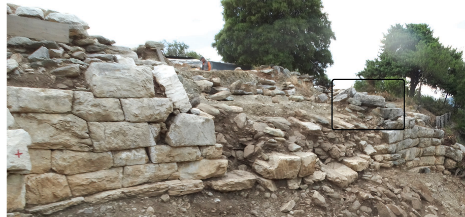
Η εξωτερική παρειά του μεταπυργίου με εγκάρσιο τοιχίο στο νοτιότερο σωζόμενο τμήμα του
