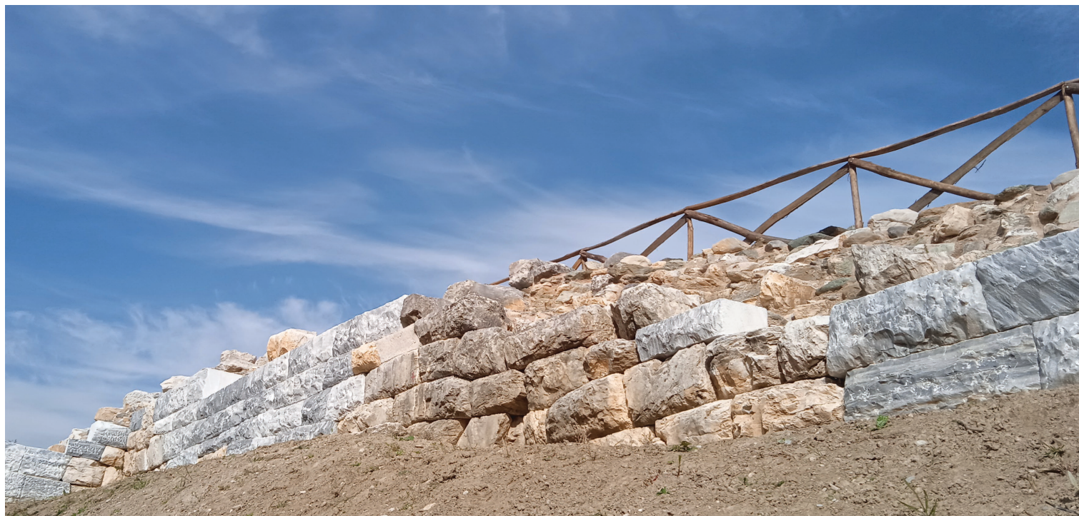
Η εξωτερική παρειά του νότιου μεταπυργίου μετά τις εργασίες αποκατάστασης
