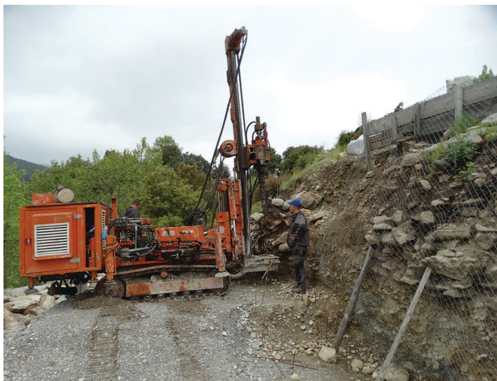
Διάτρηση και ενίσχυση του εδάφους στην υποθεμελίωση του πύργου
