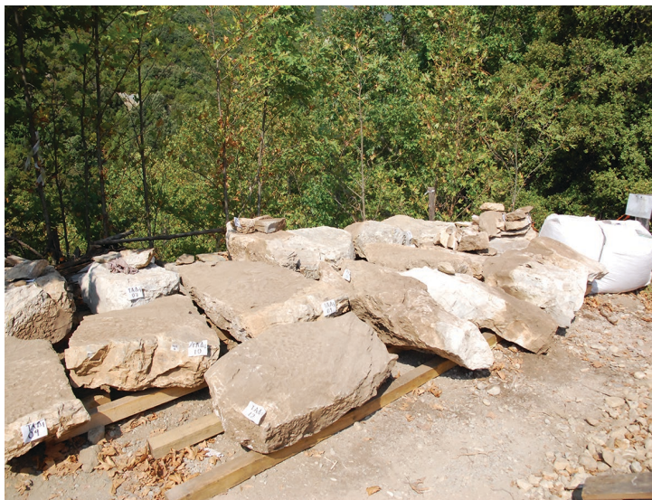
Προσωρινή τοποθέτηση λιθοπλίνθων του πύργου για τη συντήρησή τους στον εργοταξιακό αποθήκη
