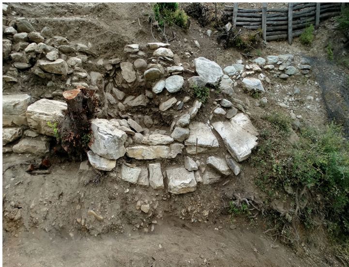
Τμήμα του νότιου μεταπυργίου με σημαντική παραμόρφωση και απώλεια δομικού υλικού
