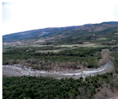
Ο ποταμοχείμαρρος της Ζηλιάνας σε επεισόδιο υπερχειλίσης κατά την πρόοδο των εργασιών
