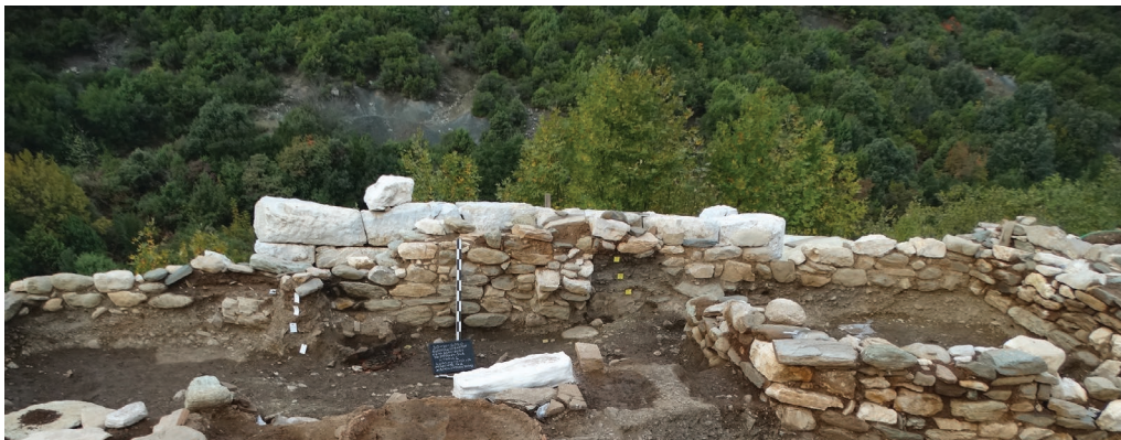
Φραγή θυραίου ανοίγματος στο δυτικό εξωτερικό τοίχο του κτιρίου
