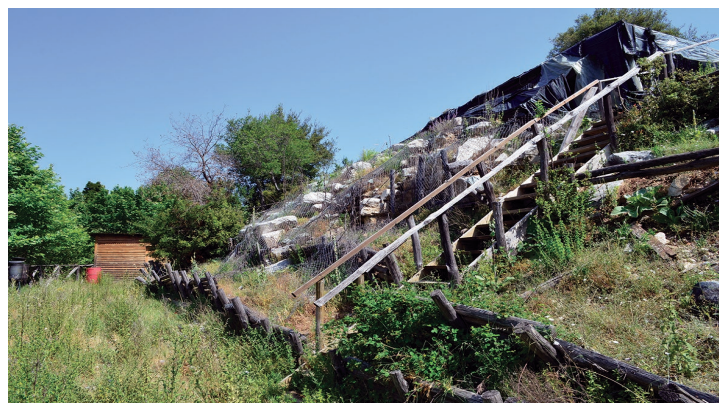
Ο πύργος Π2 και τα εκατέρωθεν τμήματα μεταπυργίων καλυμμένα με πλέγμα και πρόχειρο στέγαστρο πριν την έναρξη των εργασιών αποκατάστασης. Διακρίνεται η ξύλινη σκάλα πάνω από το τείχος που αποτελούσε την κύρια πρόσβαση στην ακρόπολη
