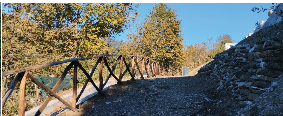
Τάφρος απαγωγής ομβρίων και ξύλινη περίφραξη εξωτερικά του τείχους
