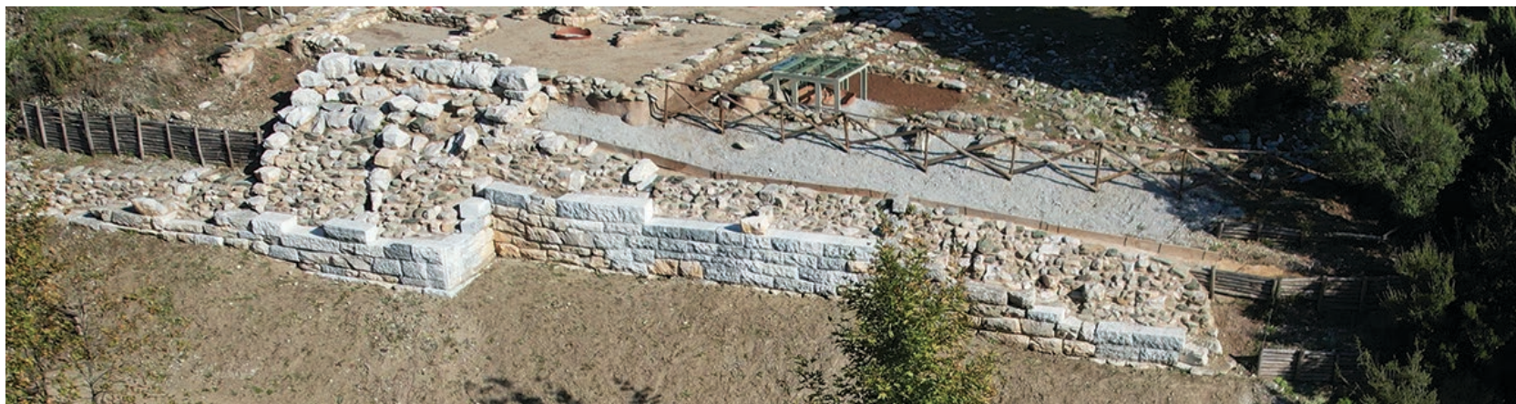
Άποψη του πύργου και των εκατέρωθεν σωζόμενων μεταπυργίων μετά τις εργασίες αποκατάστασης
