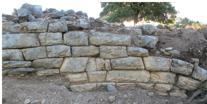
Λεπτομέρεια της βαθμιδωτής θεμελίωσης του τείχους
