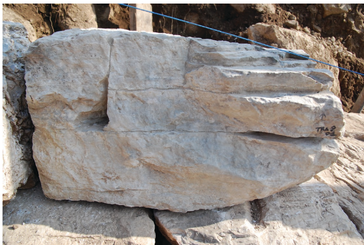
Συγκόλληση λιθοπλίνθων του νότιου μεταπυργίου (επάνω και κάτω)
