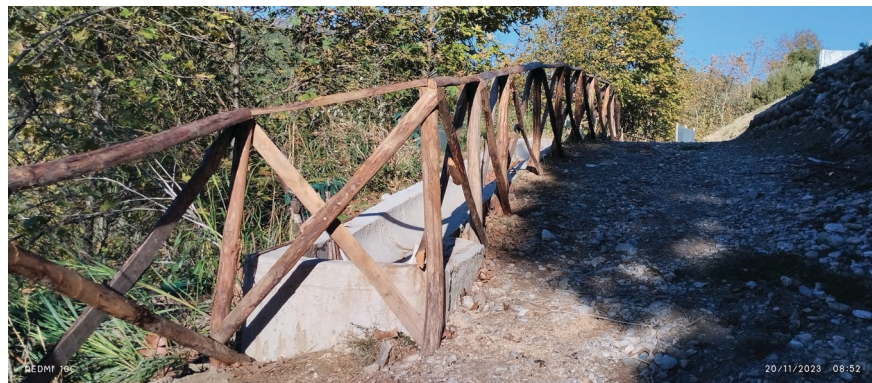
Κατασκευή περίφραξης κατά μήκος της ανόδου στο λόφο της ακρόπολης
