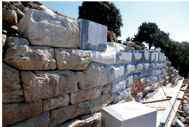
Στάδιο επεξεργασίας των λιθοπλίνθων συμπλήρωσης της εξωτερικής παρειάς του νότιου μεταπυργίου για τη συναρμογή τους με το αρχαίο δομικό υλικό
