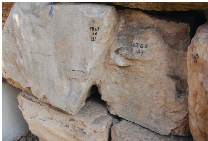
Επανατοποθέτηση λιθοπλίνθων μετά την συντήρησή τους
