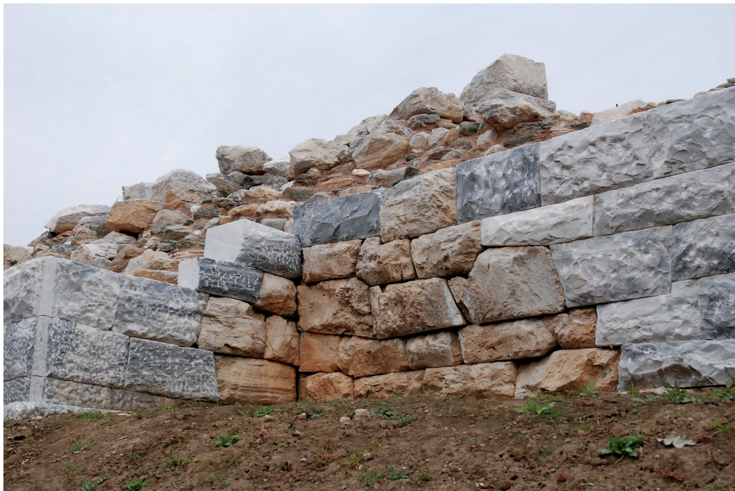
Άποψη μετά τις επεμβάσεις συντήρησης και αναστήλωσης στη συμβολή του πύργου και του νότιου μεταπυργίου
