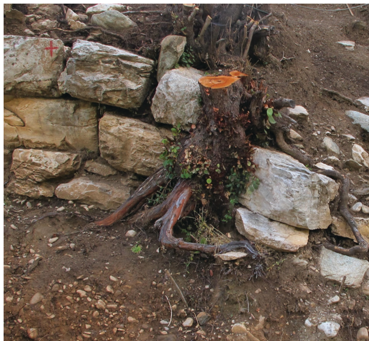
Αποψιλώσεις και κοπή των δέντρων με ριζικό σύστημα εντός του μνημείου
