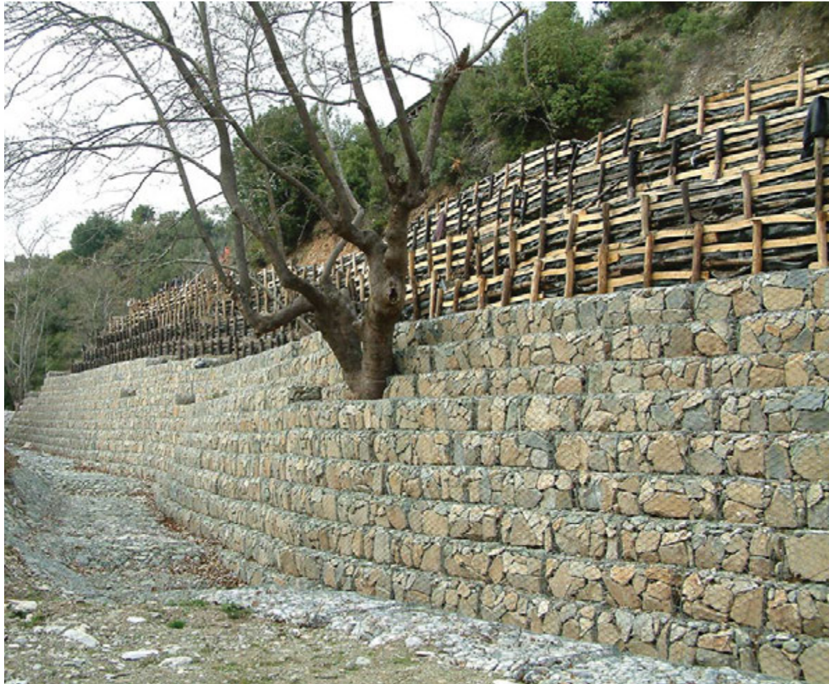
Τα πρανή της ακρόπολης και το έργο προστασίας στο χειμάρρο Καβουράλακκα.
