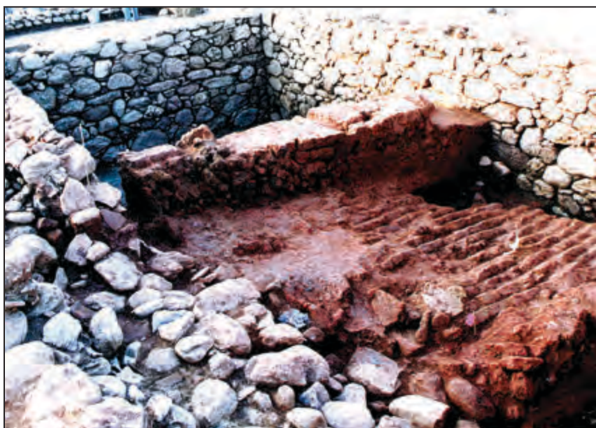
Το υπόγειο του πύργου της αγρέπαυλης, με πεσμένο στο εσωτερικό του τον πλίνθινο τοίχο.
